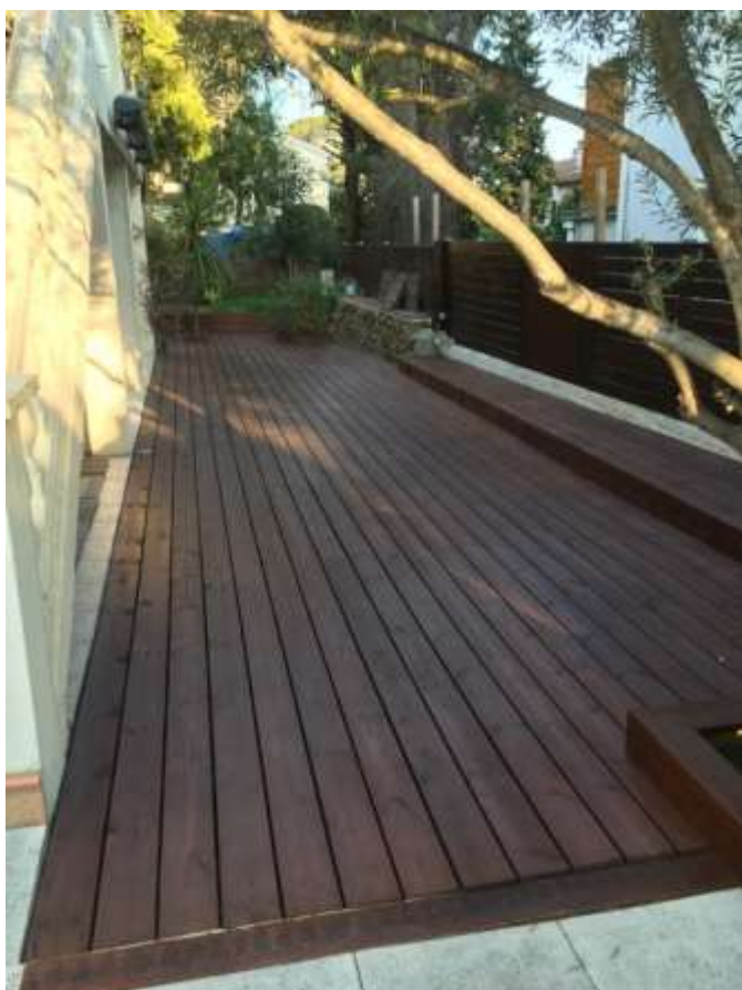
Pose de 100m 2 de terrasse en Pin Autoclave classe IV à Toulon ( Gard)
