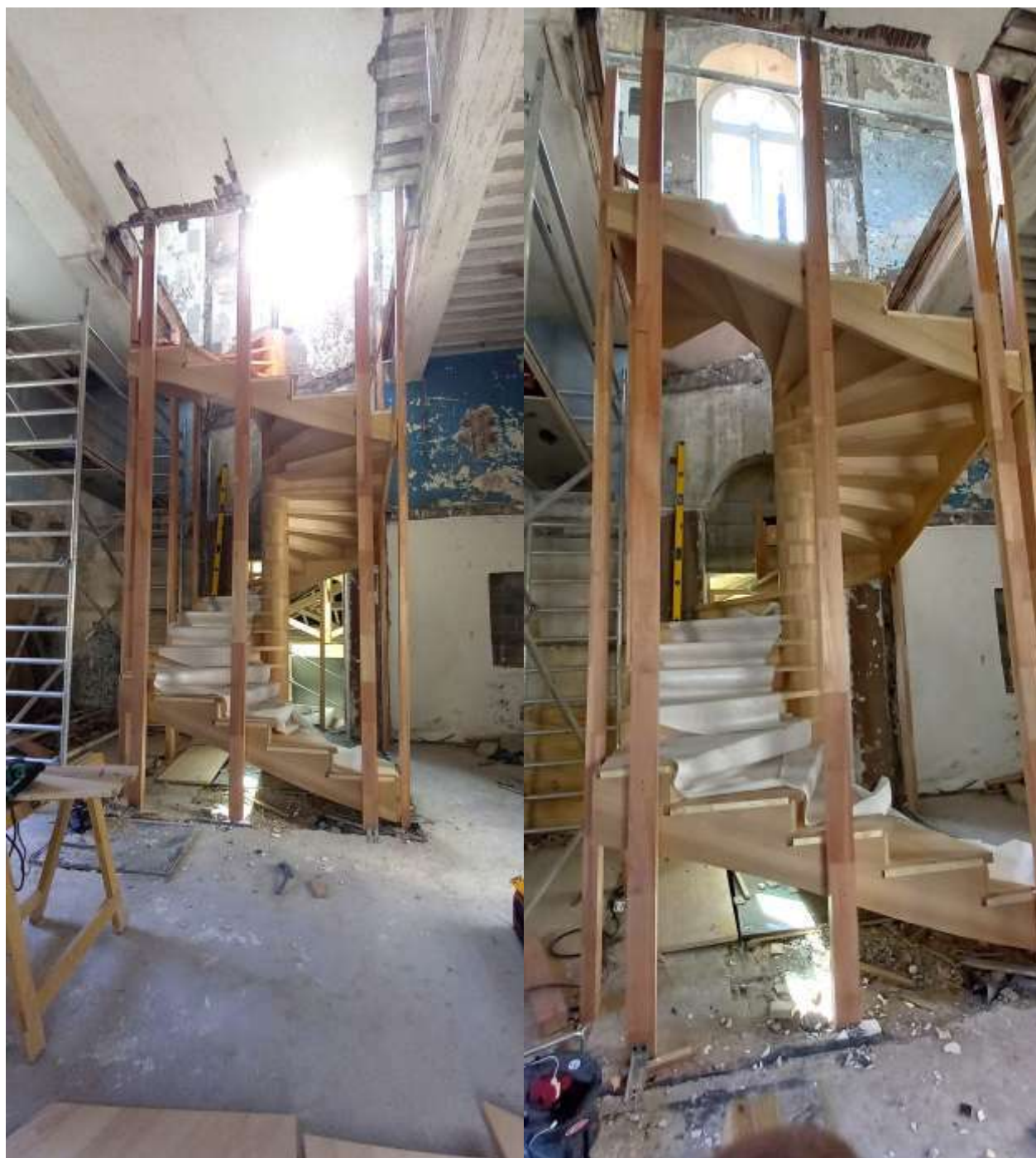
*Escalier pour la Cathédrale à Fourvière Lyon (Rhône) en sous-traitance
